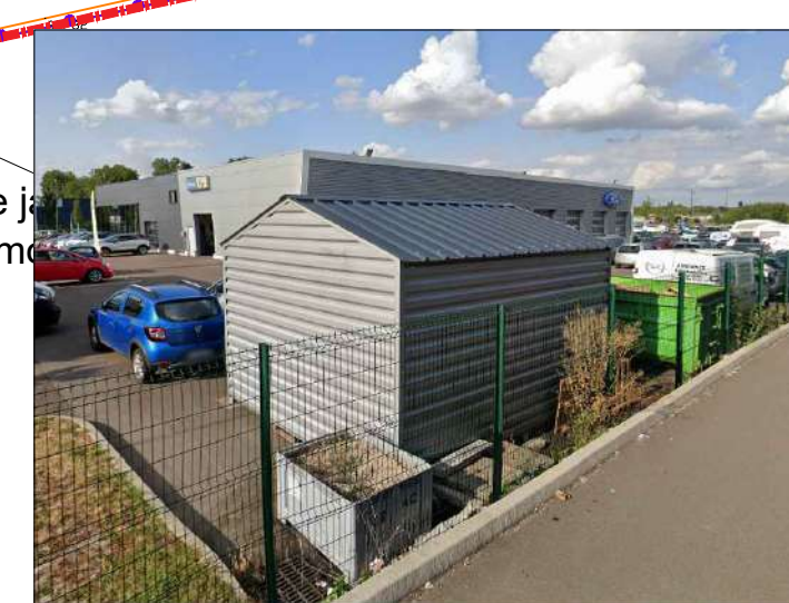
Abri de jardin à démonter
