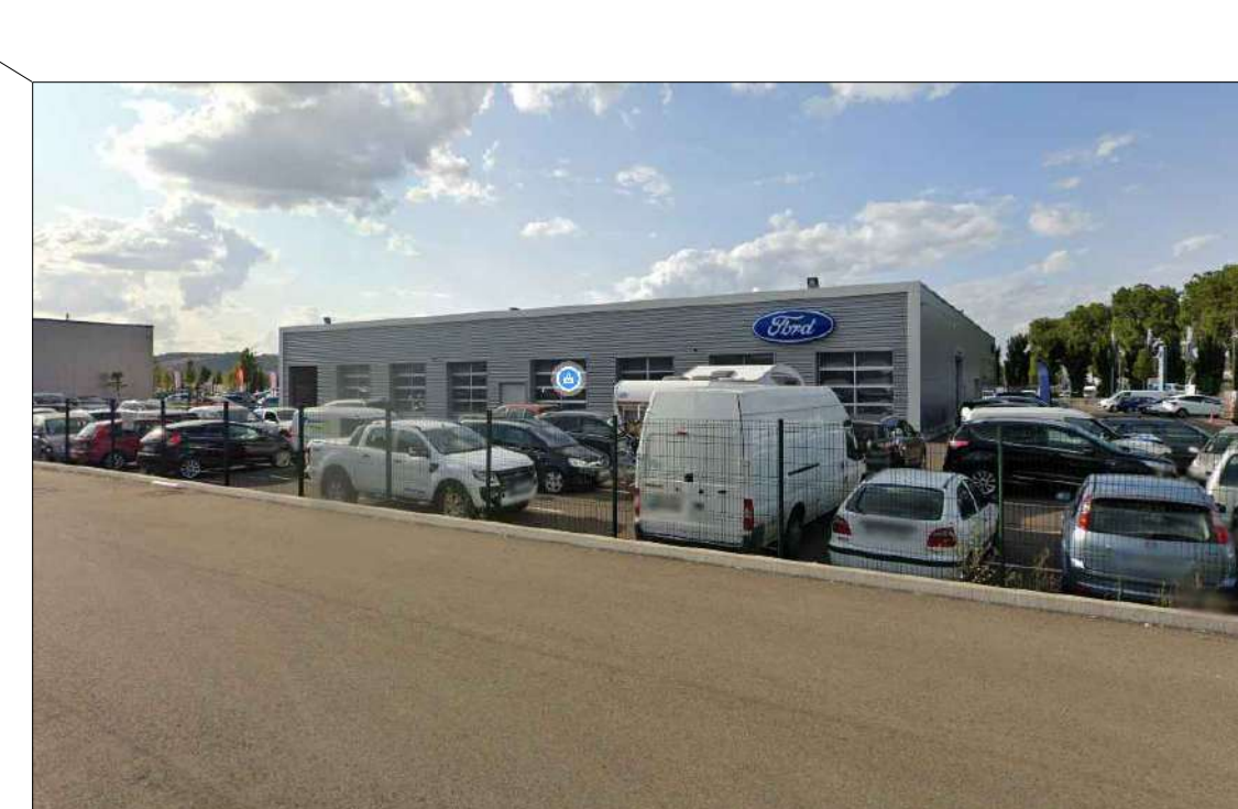
Bâtiment existant à démolir
