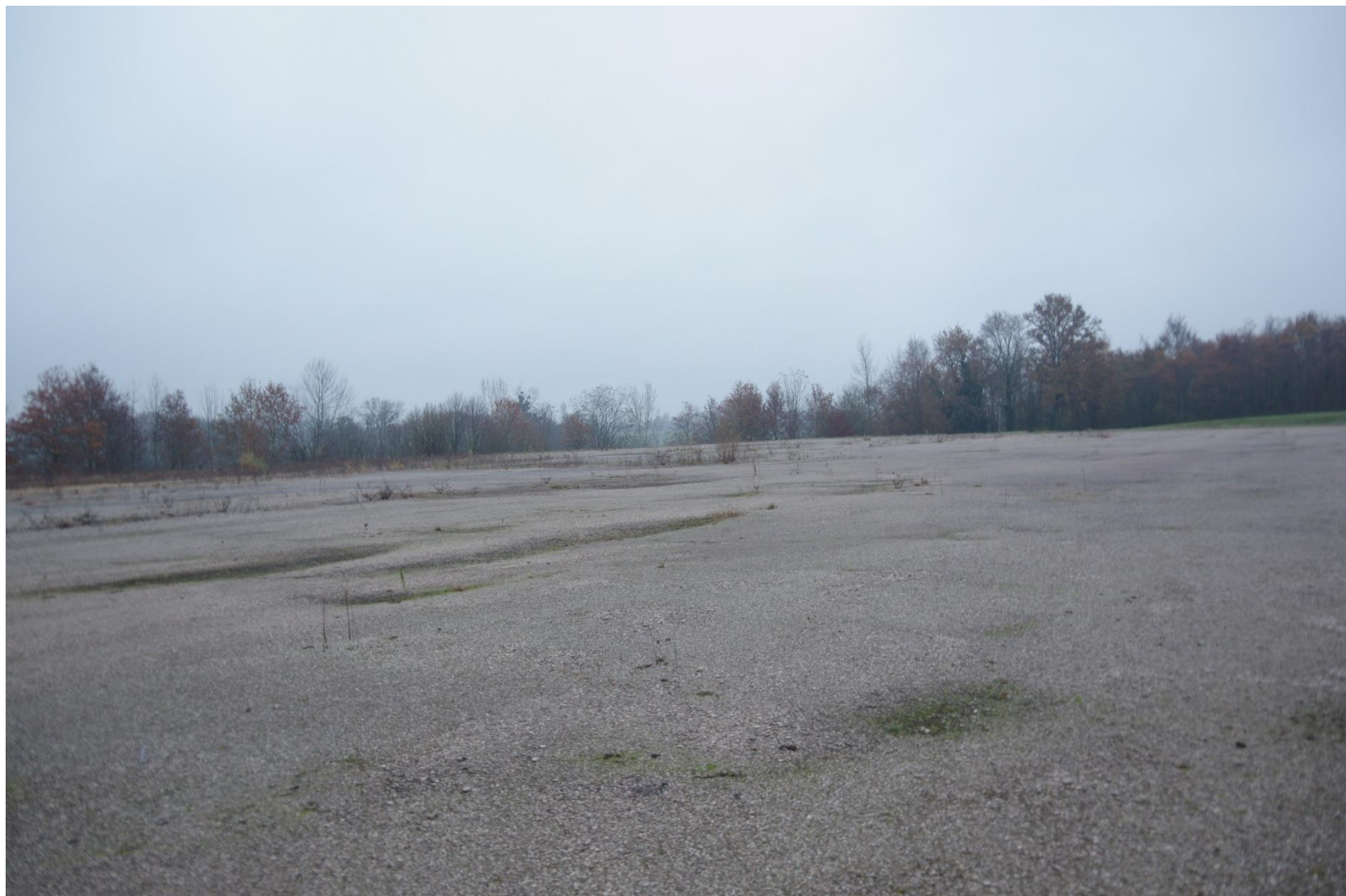
Prise de vue n°1 (Photographie datée du 28.11.2021 et prise par TotalEnergies)
