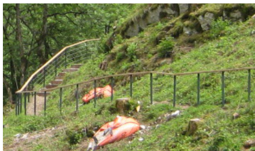
Intérêt : passage étroit, peu de terrassement Bémol : adaptation de la main courante toujours difficile
