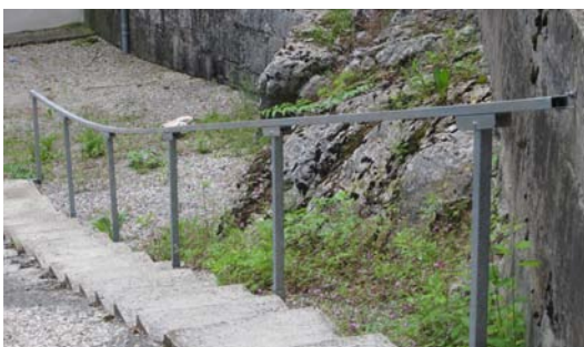
Exemple d'une main courante adaptée aux variations de pente (Source de la Loue)
