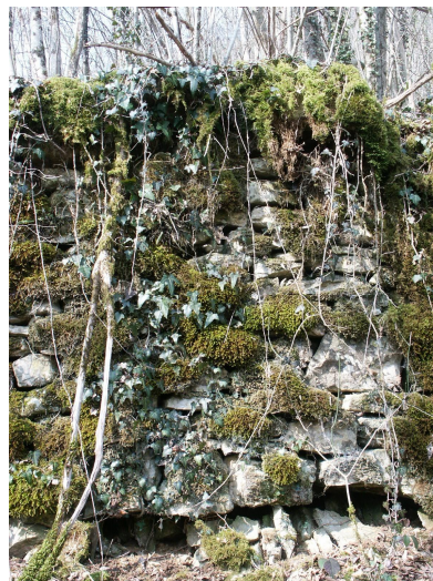
Le muret peut être sapé à sa base par un ruissellement mal canalisé. Une fois le muret abîmé, on y jette des dépôts divers.
