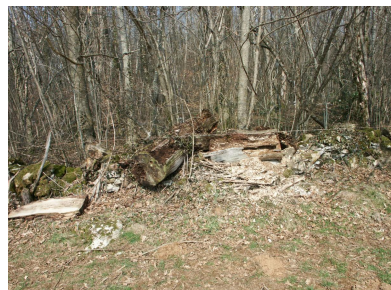
Le muret peut être sapé à sa base par un ruissellement mal canalisé. Une fois le muret abîmé, on y jette des dépôts divers.
