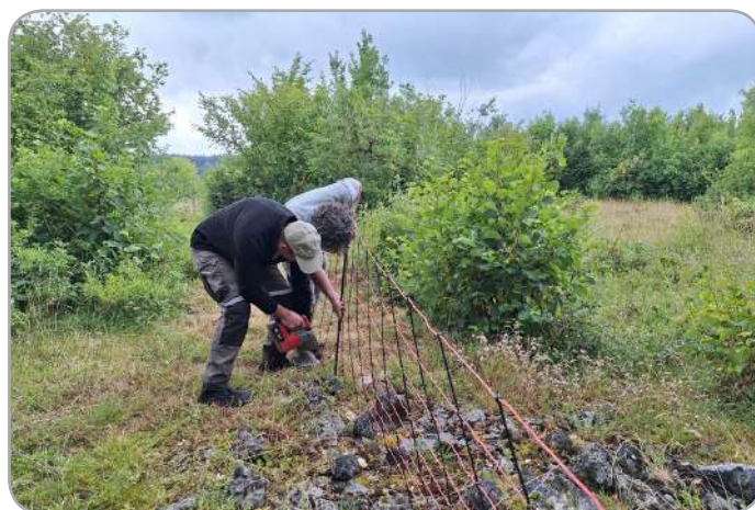
Pose de filets électriques sur le parc Podgo
