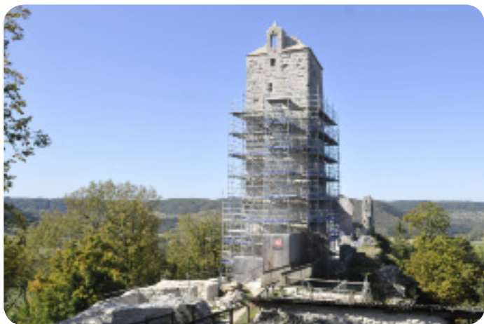
Tour Saint-Denis après consolidation © F. Ravenot
