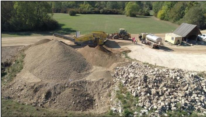
Criblage d'une partie des matériaux alluvionnaires de façon à isoler un matériau de granulométrie supérieure à 15mm. Ce matériau criblé sera destiné à l'armurage de la face amont et de la surface du banc (épaisseur de 20cm environ).
