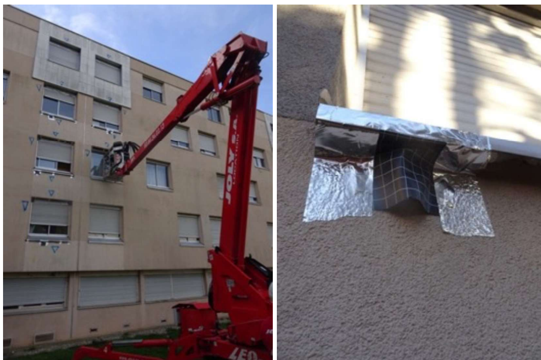
Figure 16 : Réalisation des travaux de condamnation et installation d'un système antiretour sous une tablette de fenêtre.
