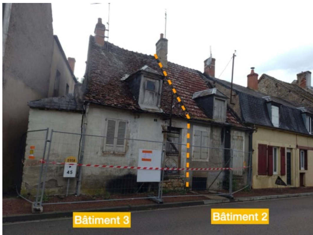
Figure 3 : Photographie des bâtiments
