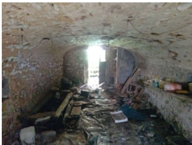
Figure 10 : cave du bâtiment 3
