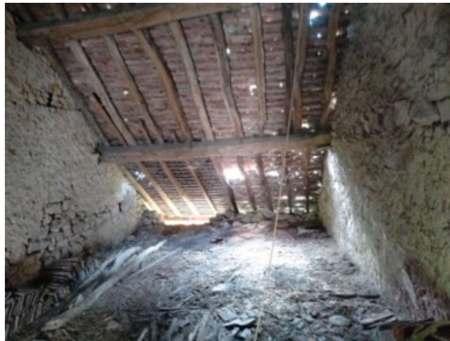
Figure 11 : Comble du bâtiment 2
