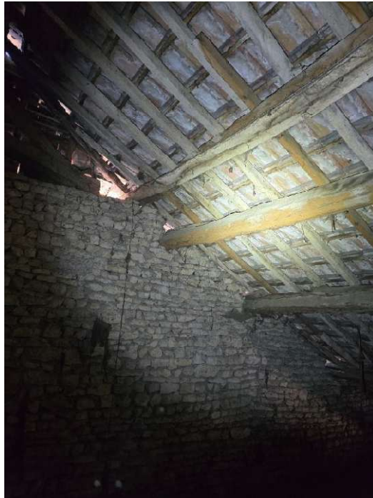
Figure 16: comble du bâtiment
