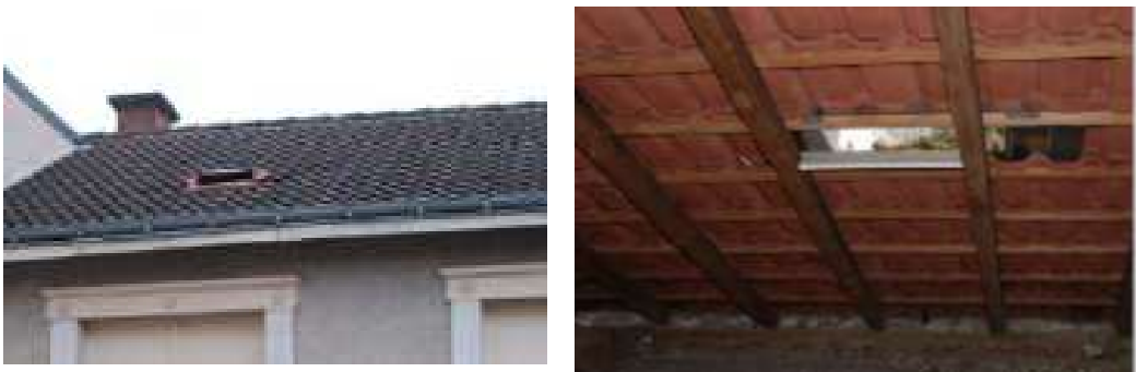
Figure 32 : Exemple de chiroptières sur tuile apparente (Recueils d'expériences des aménagements pour une meilleure cohabitation chiroptères-homme en milieu bâti, SFEPM)
