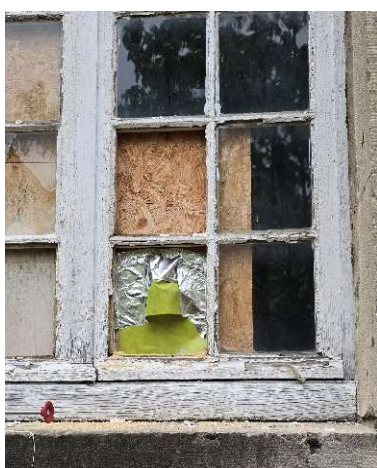
Figure 31 : exemple de système anti- retour
