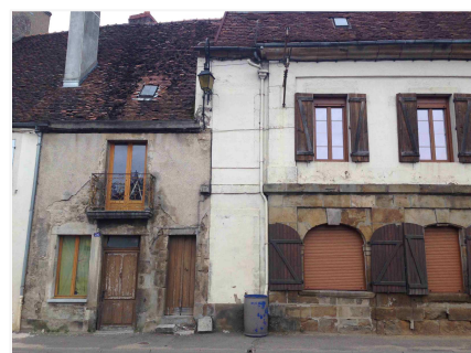
Exemples de logements vacants le long de la rue Pasteur, ancienne RN6
