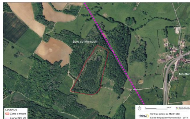
Réseau de transport d'électricité
