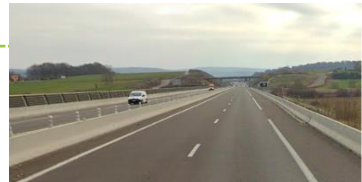
EXEMPLE DE SECTION À 2 x 2 VOIES : LA RN19 À L'EST DU PROJET, À LA HAUTEUR DE BOTANS (source : googlemap)
