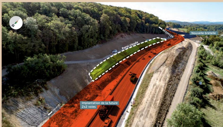
Les travaux de déblais dans cette zone doivent être effectués de manière coordonnée avec l'édification d'une paroi clouée. C'est un soutènement léger constitué d'une paroi en béton projeté, armée d'un treillis ancré par des clous disposés quasi horizontalement. Il est réalisé au fur à mesure que les matériaux sont déblayés afin de stabiliser le talus. Cette paroi clouée permet de limiter les emprises du côté du bois de Miserey-Salines.
