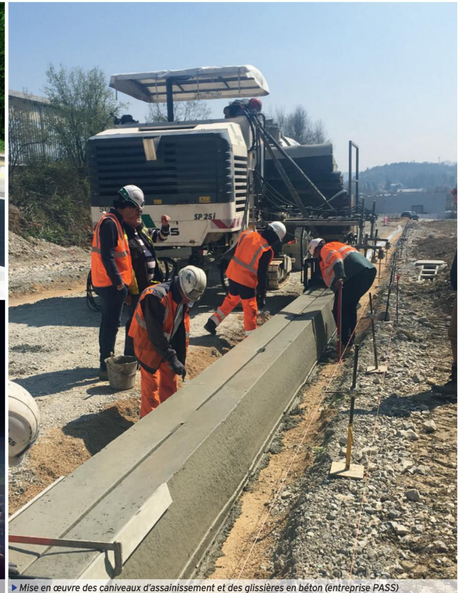
► Mise en œuvre des caniveaux d'assainissement et des glissières en béton (entreprise PASS)
