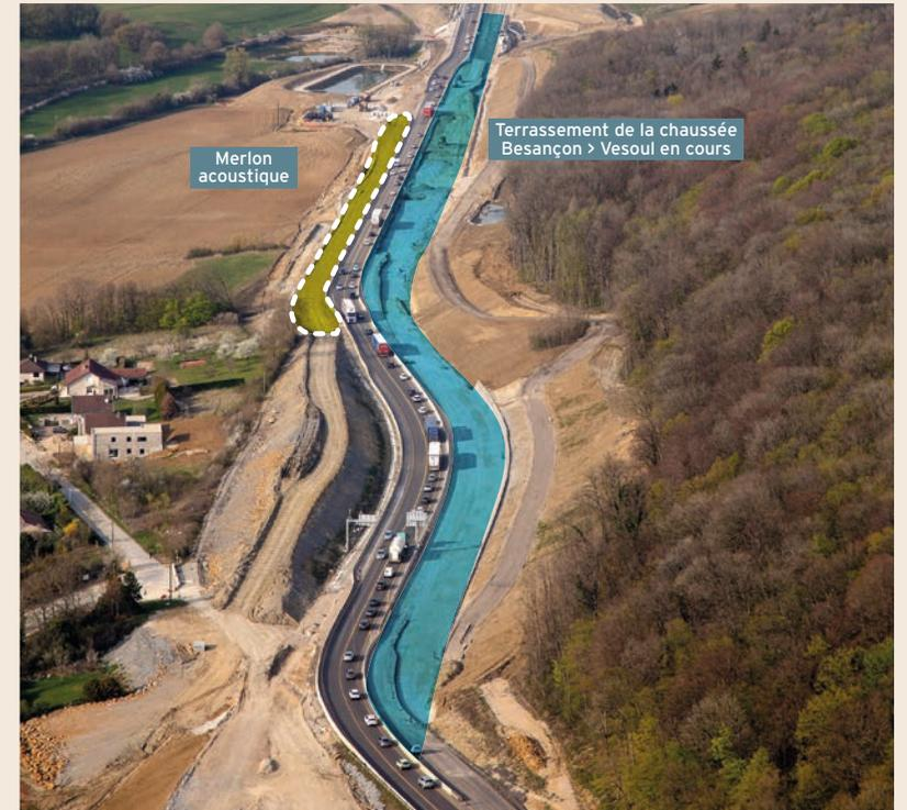
La construction de la structure de la demi-chaussée du côté Est prend fin. Les usagers pourront circuler sur cette demi-chaussée d'ici cet été, une fois le revêtement de la chaussée posé. Les travaux pourront alors se poursuivre sur la demi-chaussée côté Ouest.
