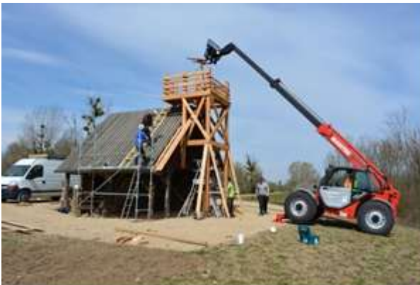
Installation de la plateforme d'observation
