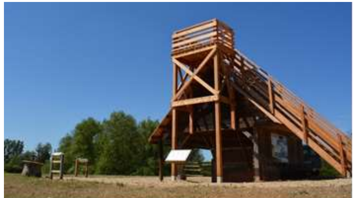
Vue d'ensemble du pôle pédagogique
