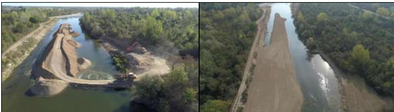
Travaux banc et encoche nord (Vue de l'amont vers l'aval)
