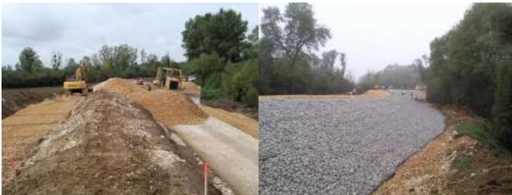
Photos des travaux (crédit FX DUPRESSOIR)
