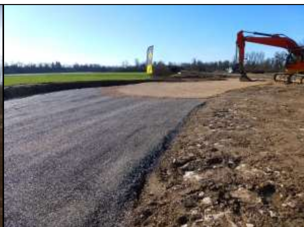
Couche bitumineuse assurant l'étanchéité du site (enlevée après travaux)
