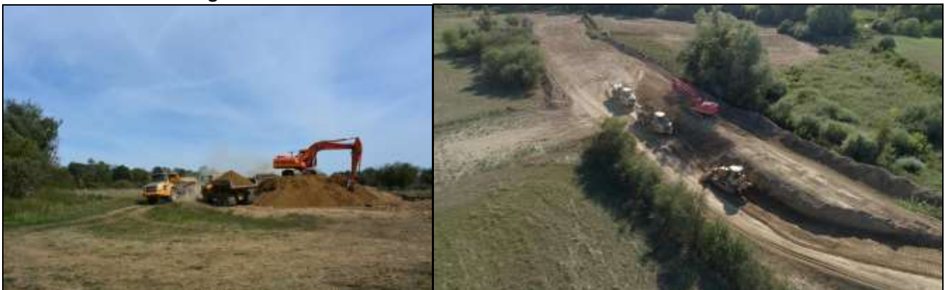
10 septembre : début démantèlement
