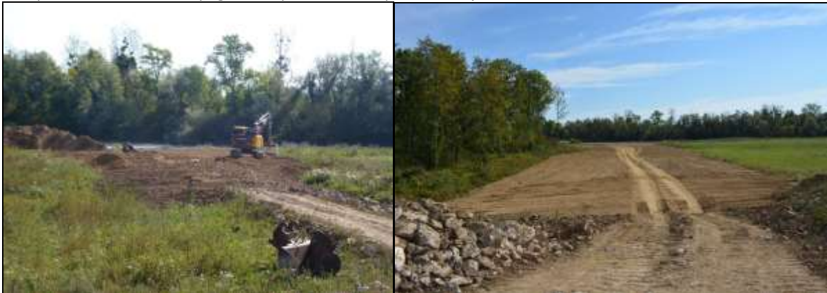
Démontage du dernier casier en place
