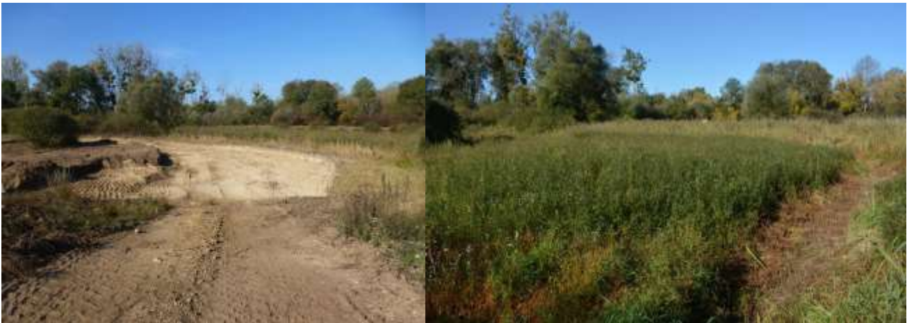
Durant travaux (octobre 2018)
