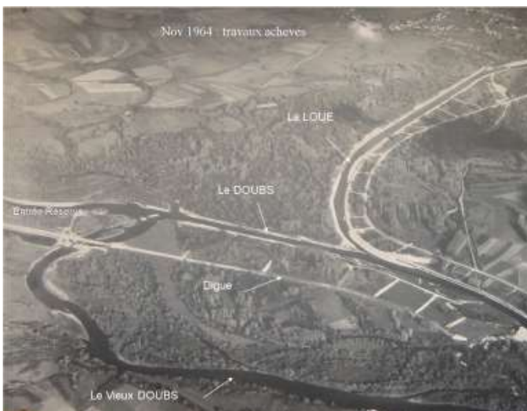
Figure 13 : Vue aérienne de la réserve à la fin des travaux (1964) (Source : DDT du Jura)
