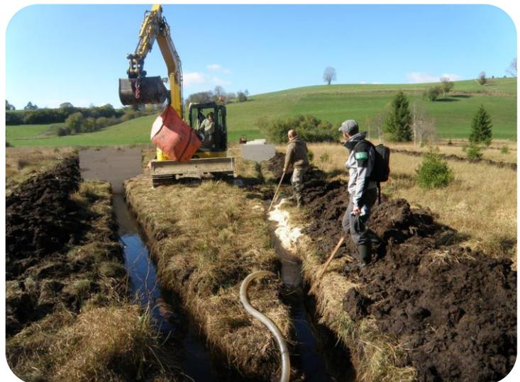
Figure 18 : Comblement des drains du bas-marais du Crossat (2014)
