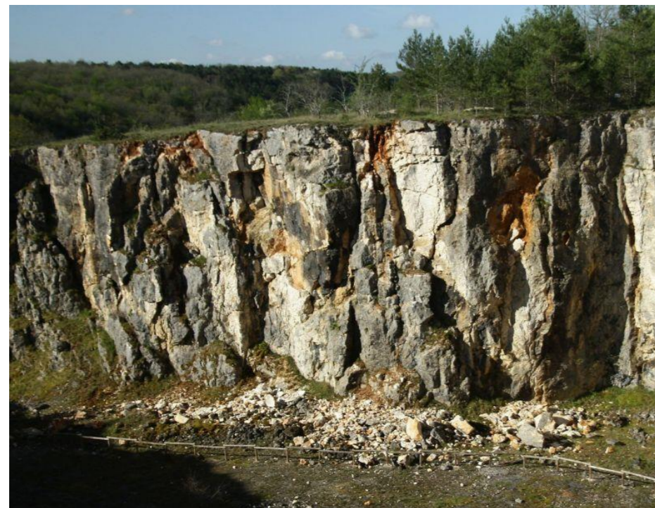
IP1 : travaux de purge de la carrière
