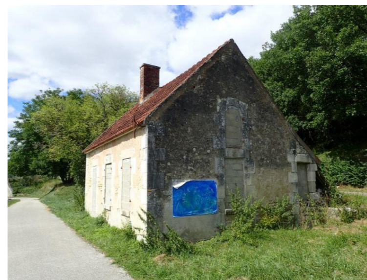
EI3 : maison éclusière
