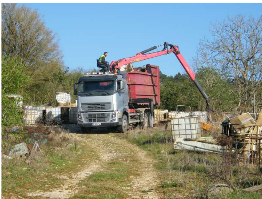
Enlèvement des cuves le 14 avril 2021 (cliché Hugues Pinston).
