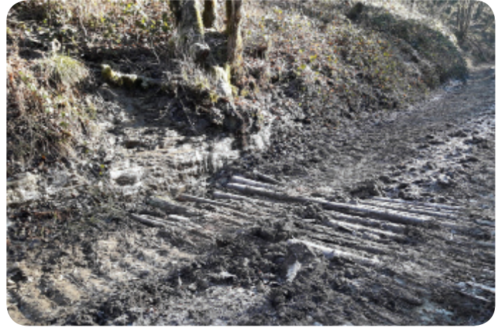
Mise en place de rondins pour franchir le gué © D. Langlois
