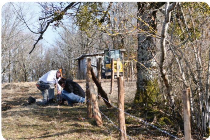
Réfection de la clôture entre les pelouses Martin et Podgo © F. Ravenot
