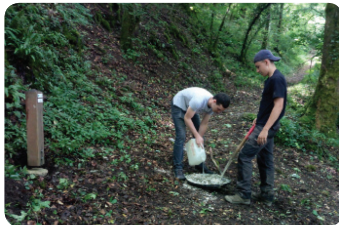
Scellement d'une borne signalétique © F. Ravenot
