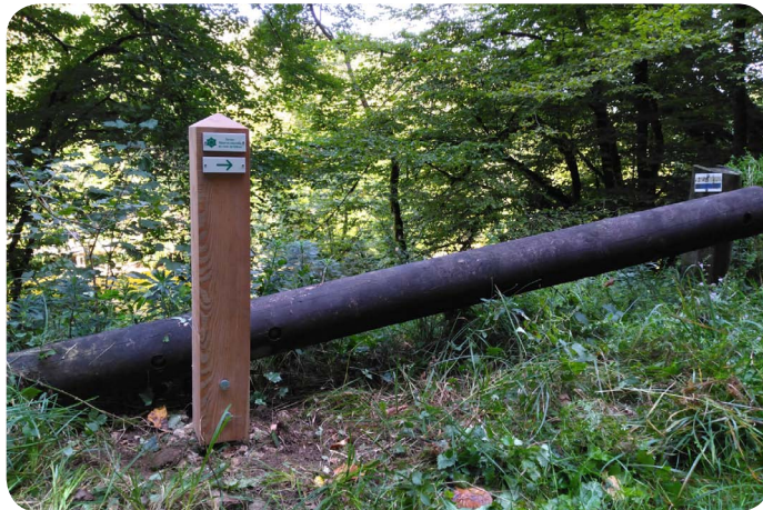
Remplacement d'une borne directionnelle du sentier de la RNN
