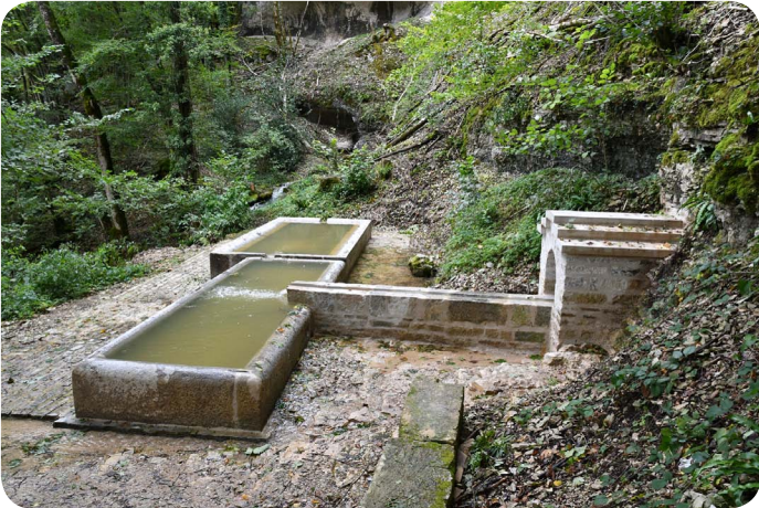
La fontaine de Léri après restauration
