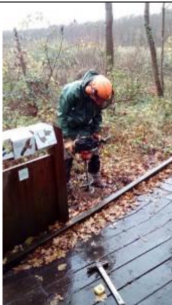
Préparation des trous pour la mise en place des poteaux - CenB
