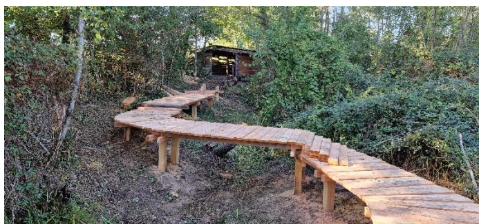
Réfection de l'ancien pilotis conduisant à l'observatoire ornithologique – G.Aubert - CenB
