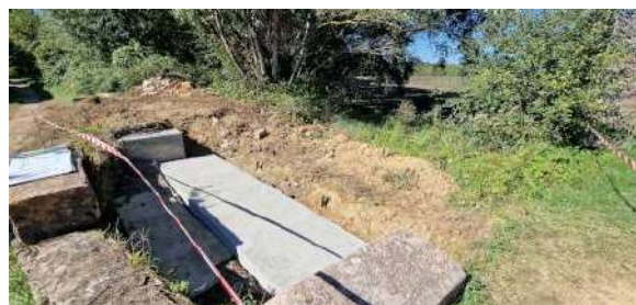
Démontage des anciens équipements / reprise des bajoyers et terrassement de seuil
