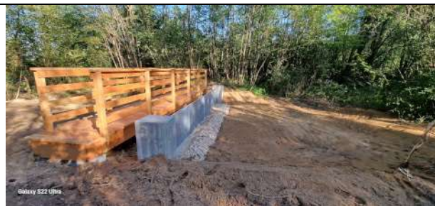
Après travaux et pose de la passerelle
