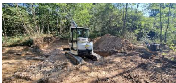
Terrassement en cours (création fondations après effacement de l'ancien ouvrage)
