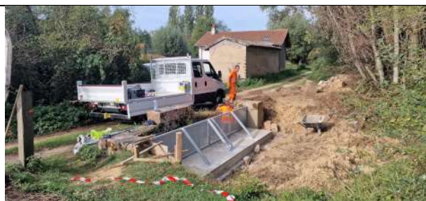
Pose de grille et finition en cours
