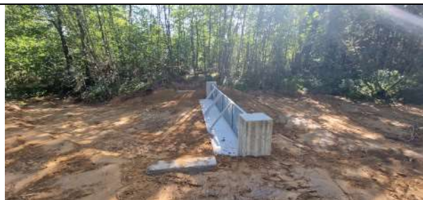
Terrassement de seuil, création de bajoyers, mise en place d'une grille
