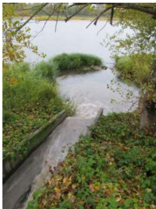
Un des déversoirs d'orage des quais de La Charité-sur-Loire en fonctionnement. BF-CENB
