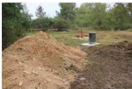
Déblais liés au forage
