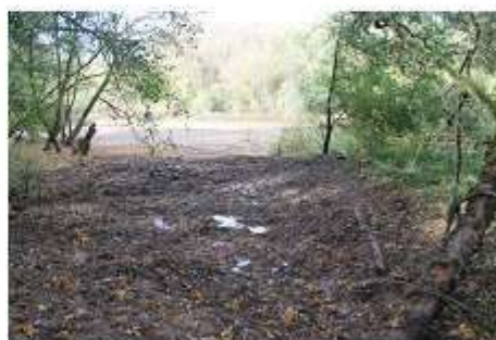
Chemin d'accès après remise en état
