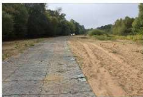
Plaques rigides installées au niveau du bras secondaire
