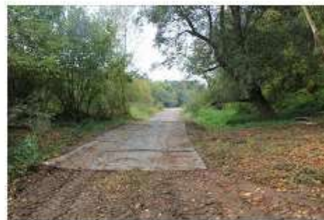
Plaques rigides installées pour l'accès au bras
