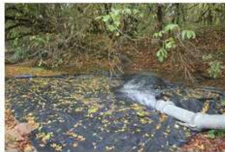
Bâche positionnée au point de rejet
