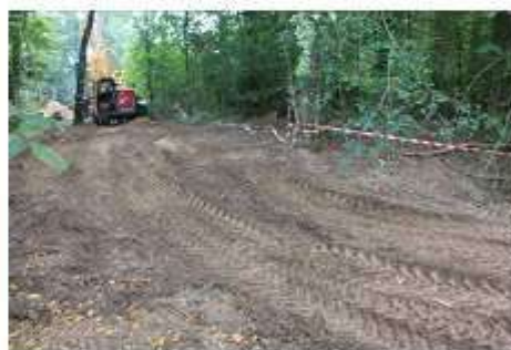
Décapage de terre végétale
