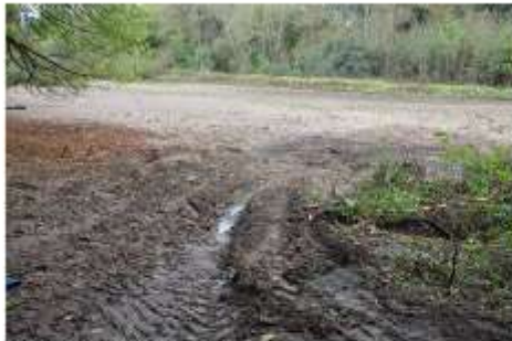
Ornières en pied de berge
