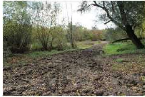
Accès au bras secondaire depuis le franc-bord après démontage des plaques rigides et décompactage
