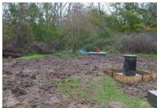
Plate-forme de forage après réglage
