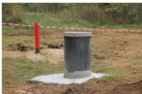
Puits de forage et piézomètre
