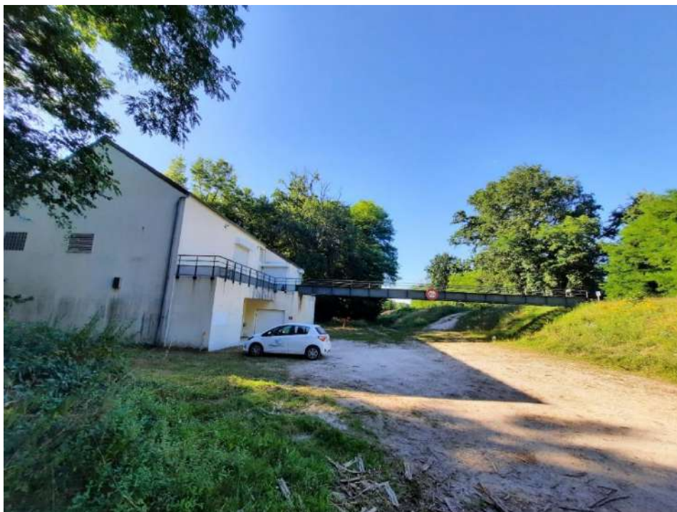
Figure 44 : Vue de la passerelle depuis le chemin
