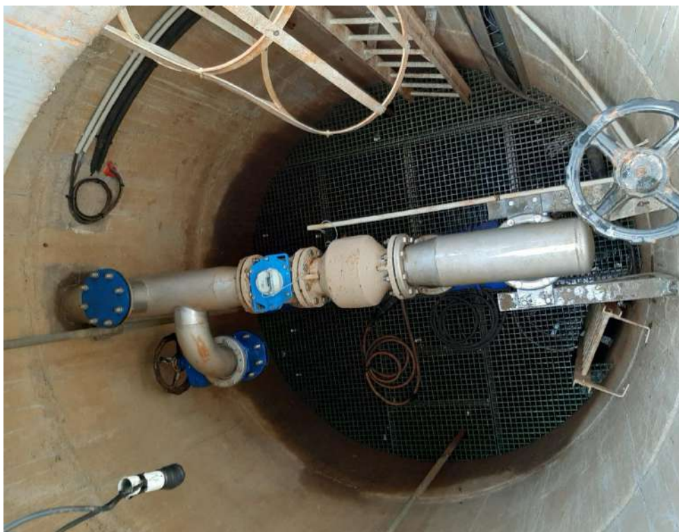
Figure 62 : Vue de l'intérieur d'un puits existant
