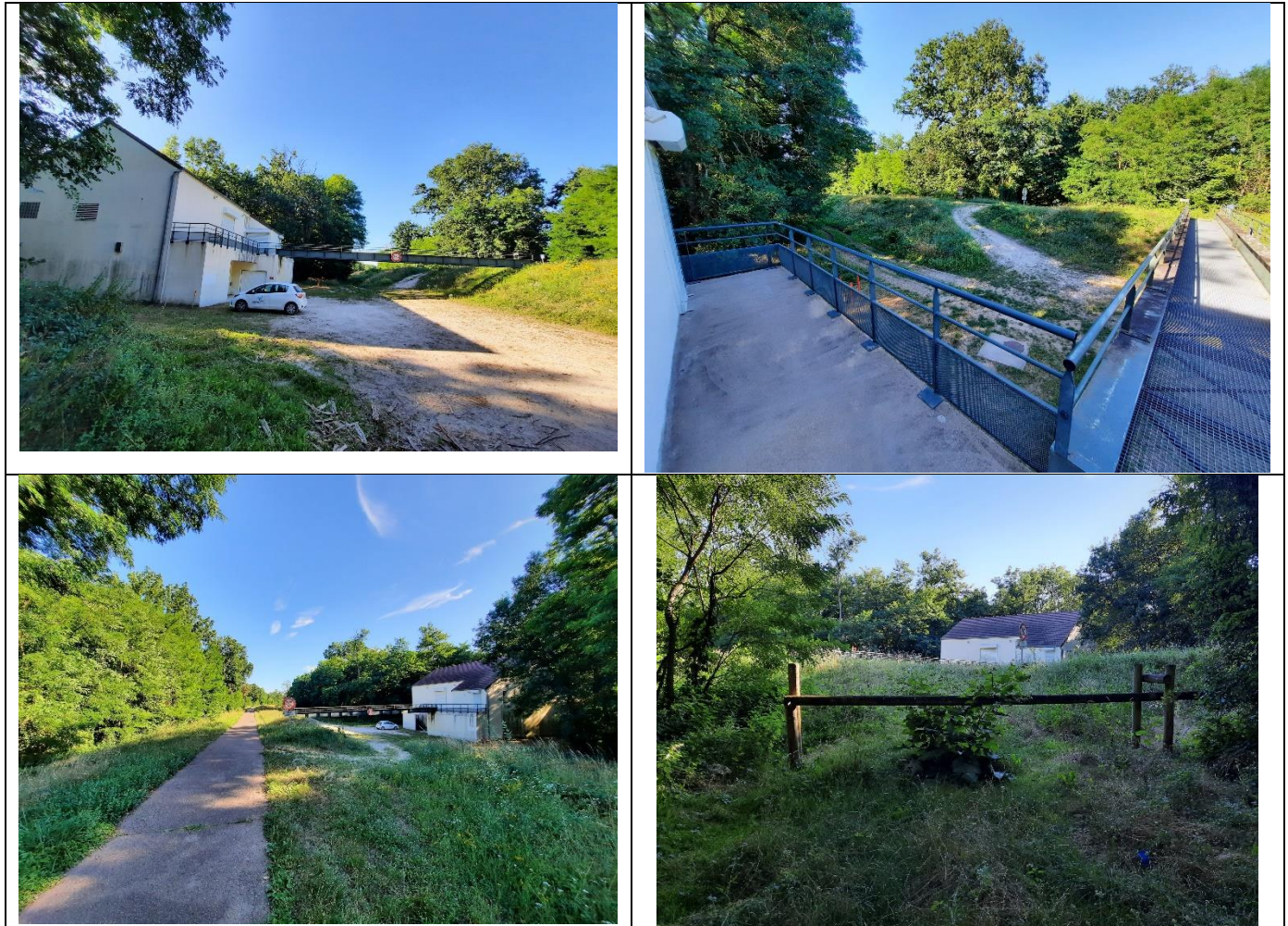
Figure 2 : Photographies du tronçon de digue et chemin objet de la présente étude
