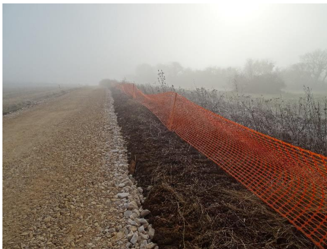
Balisage de chantier
