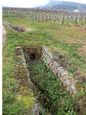
Le pavement des fossés avec une pierre locale est mieux intégré dans le paysage qu'un fossé d'écoulement en béton
