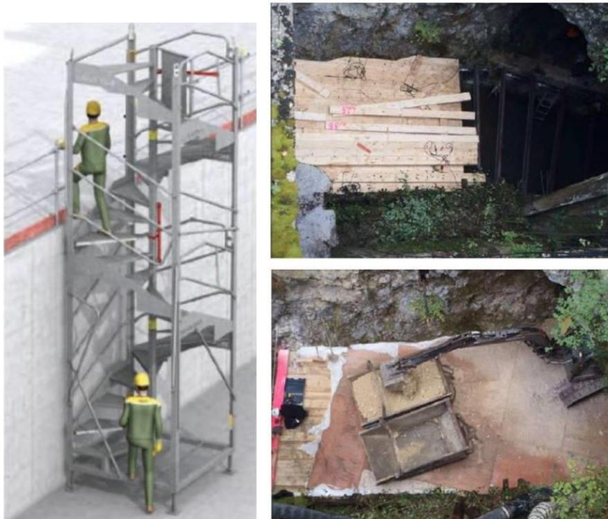
Figure 4 : Illustration d'escalier temporaire (à gauche) ; Exemple de plateforme d'accès à la galerie (à droite)
