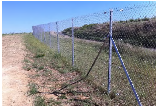
Figure 5-8 : Exemple de clôture (source : TSE)
