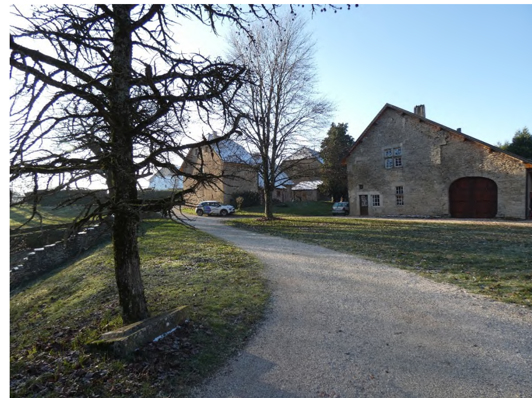
Photographie 6 Château d'Etrabonne (source: TAU W France)
