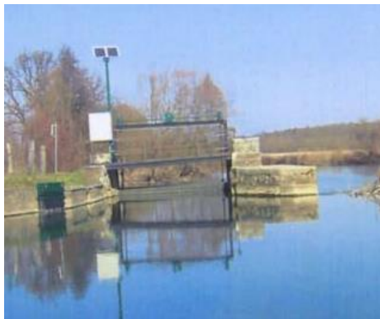
Photo de la vanne de décharge sur le barrage de Moncley
