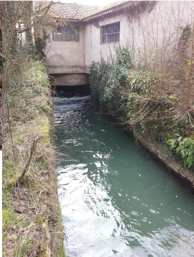
Zone implantation turbine siphon, entre les murs existants : 8 m de longueur par 4 m de largeur.
