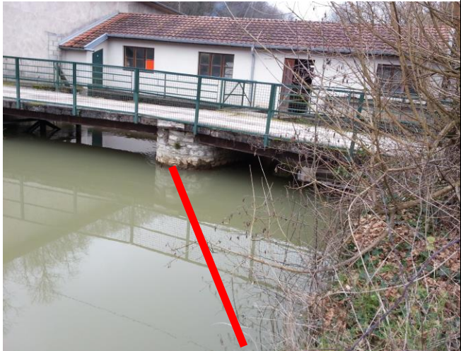
Drome flottante et emplacement du batardeau par remblai, pendant la durée des travaux.
